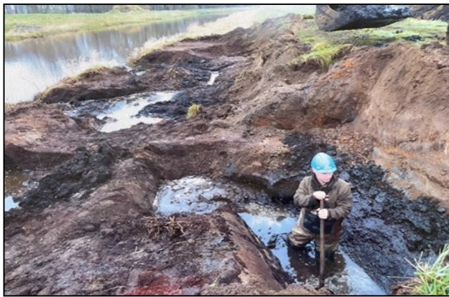
Figure 1: Excavated beaver tunnel system, Hunze een Aa's, NL, where 400 linear meters of vertical barrier had been installed by IWT in Oct. 2021, (Source: Waterschap Hunze een Aa's)
