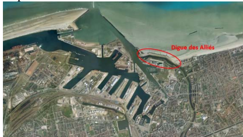
FIGURE 1 : LOCALISATION DE LA DIGUE DES ALLIES (FOND GOOGLE EARTH)
