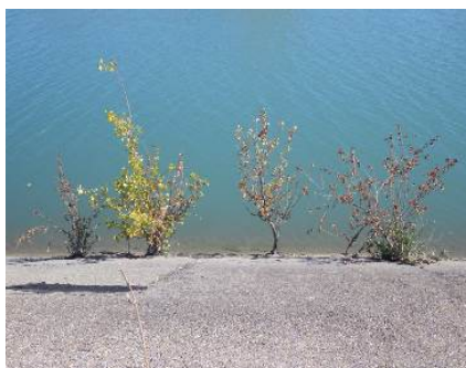
FIGURE 2 : JEUNES LIGNEUX IMPLANTES DANS UN REVETEMENT ETANCHE EN COURS DE DEPERISSEMENT, SUITE A DEVITALISATION
